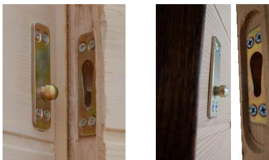
Figura C-1: Sistema di ganci interni
