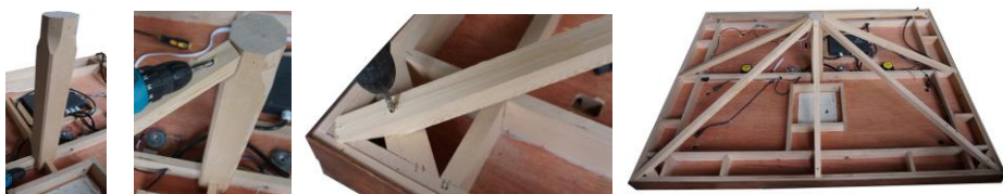
Figura I-6: Installazione delle travi di supporto del tetto
